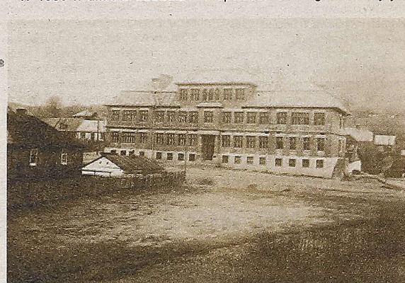
Nowa szkoła prawie gotowa
