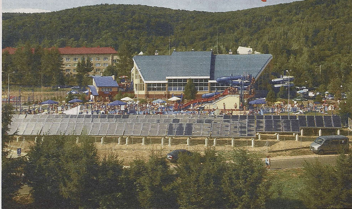
Na skarpie poniżej basenów otwartych zainstalowanych zostało 120 kolektorów słonecznych
