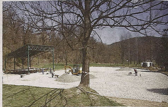
Na wiosnę budowano dojście i plac z kostki brukowej
