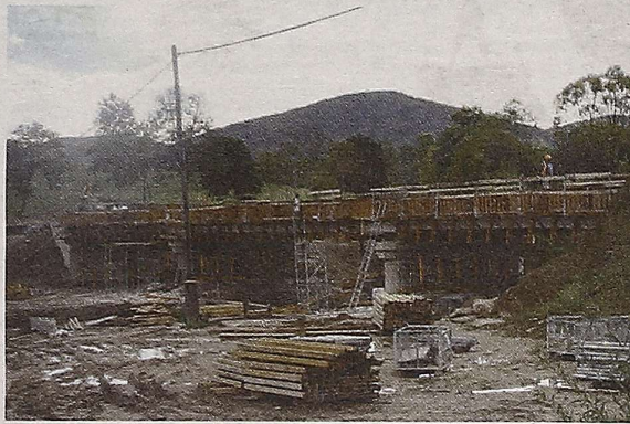
Konstrukcja mostu już stoi
