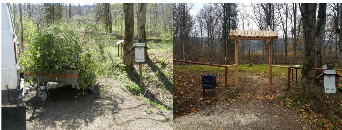
Rozpoczęcie prac mających na celu odnowienie cmentarza greckokatolickiego w Sereńnicy – oczyszczenie terenu oraz wykonanie ogrodzenia.
