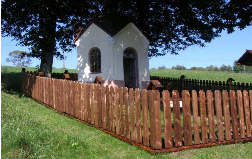
Efekt końcowy wykonania nowego ogrodzenia przy kapliczce.
