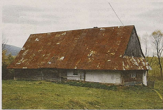
Lipie – jeden z domów pochodzących z tamtych lat, pierwotnie kryty słomą, z czasem słomiany dach zastąpiono blachą, dobudowano także komin Fot. Z. Krasowski
