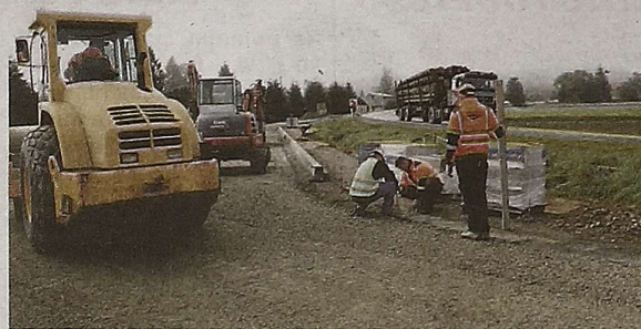
W Hoszowie powstaje punkt kontroli samochodów ciężarowych Fot. Andrzej Górski
