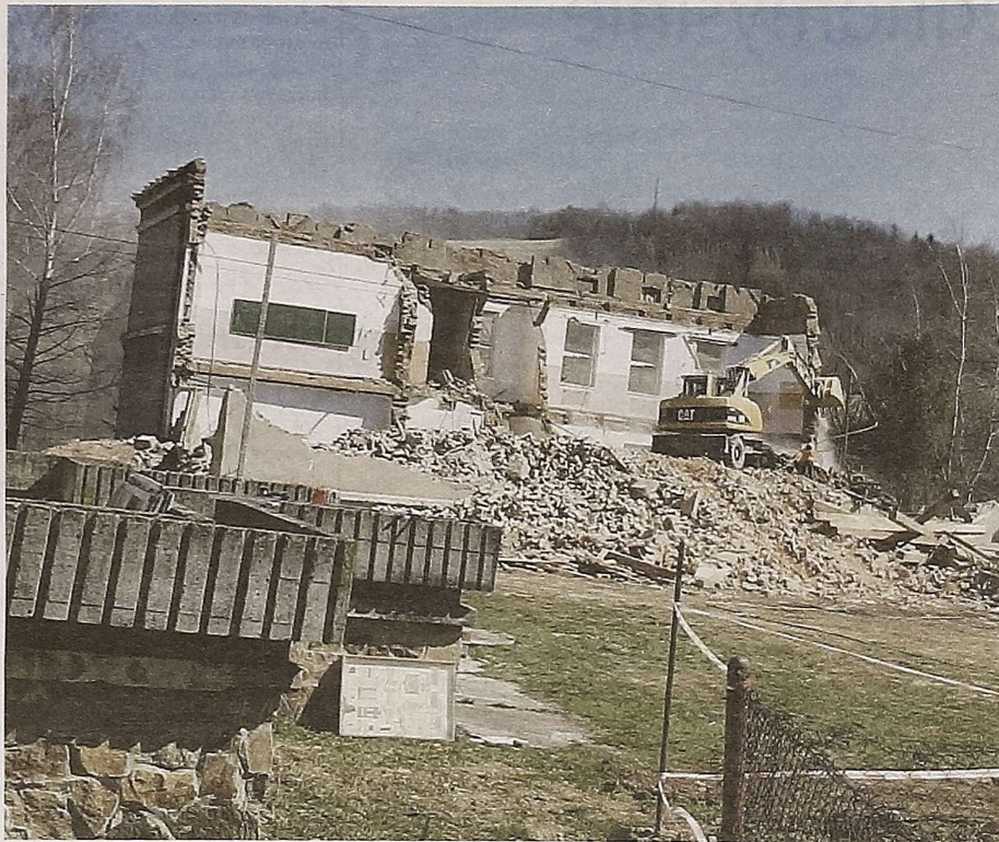
Rozbiórka starej, wzniesionej jeszcze przed pierwszą wojną światową, szkoły w Baligrodzie. W jej miejscu powstaje dom pomocy dla 30 pensjonariuszy. FOT. ARCHIWUM URZĘDU GMINY W BALIGRODZIE
