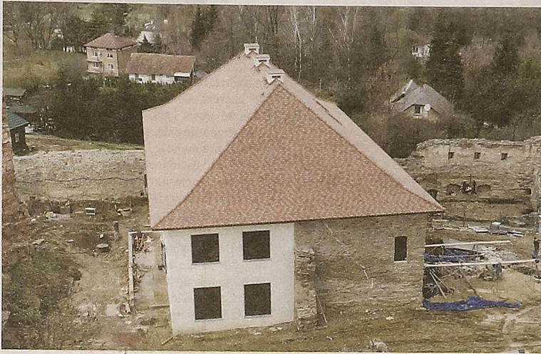
Między wiekowymi murami powstaje nowy budynek. FOT. JAKUB OSIKA
