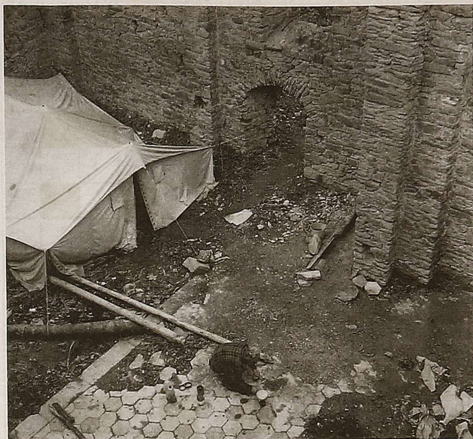
Rok 1973. Olgierd Łotoczko podczas prac rekonstrukcyjnych posadzki w zrujnowanej cerkwi w Łopience
