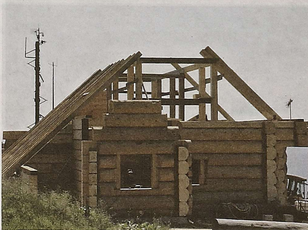
Budowa Chatki Puchatka na Połoninie Wetlińskiej. Stan z 26 lipca 2021 roku
