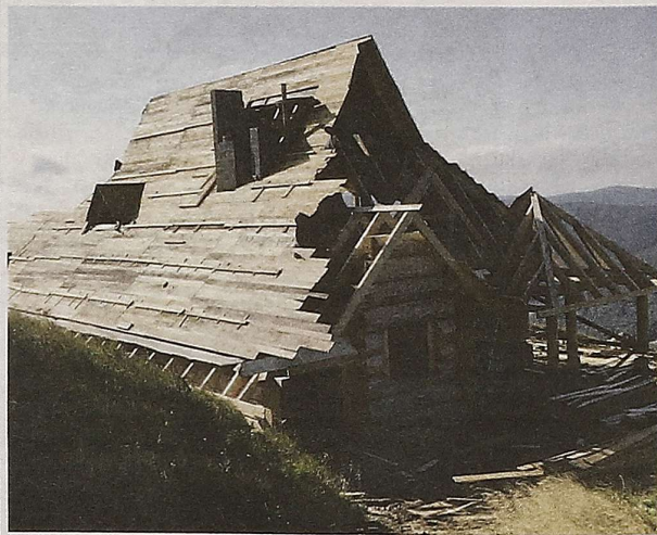
Schronisko w budowie FOT. ARCHIWUM FIRMY REMONTOWO-BUDOWLANEJ „PIOTROWSKI”
